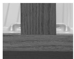
4) Una vez que la bandeja sea ajustada dentro del gabinete, utilice silicon adhesivo alrededor de todo el perímetro y cualquier orificio que usted haya hecho para la tubería. Tenga cuidado de sellar todos los cortes para evitar cualquier fuga de agua.
